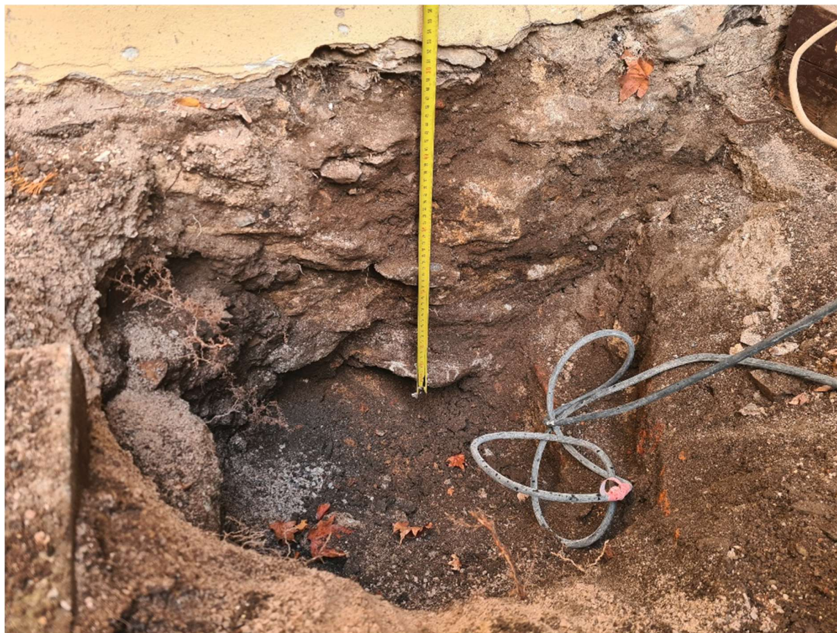
Kopaná sonda u štitové stěny v atriu č.p. 88 v místě novodobého vstupního otvoru, základ zastižen v hloubce 53 cm, tedy značně mělko.
