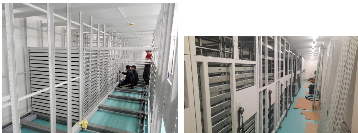
Montáž pojízdných regálů v 1.NP
