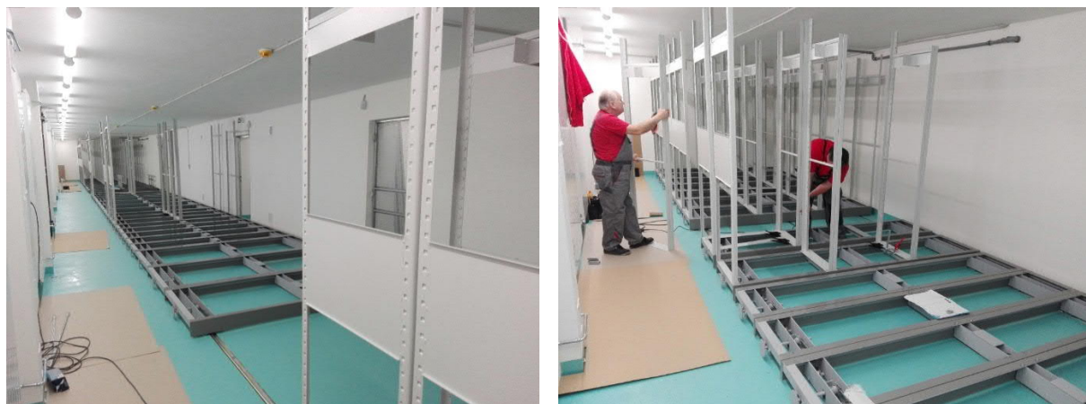
Montáž pojízdných regálů v 1.NP
